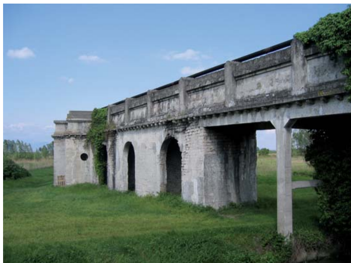
Edificio e opere di collegamento dell'antica idrovora
