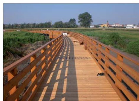
Cantiere: lavori di realizzazione della passerella ciclopeditone in legno
